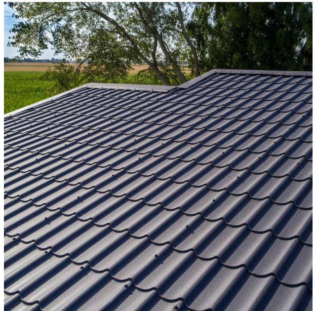
Dachgestaltung mit JI Permapan PIR.
