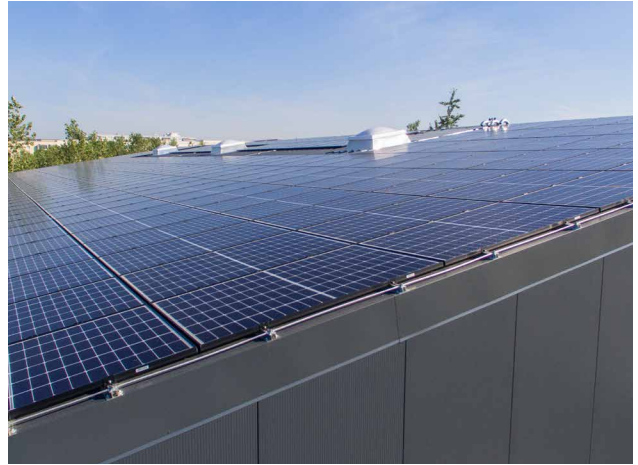
Jl Roof PIR als Dachbedeckung und Träger für eine Solaranlage.
